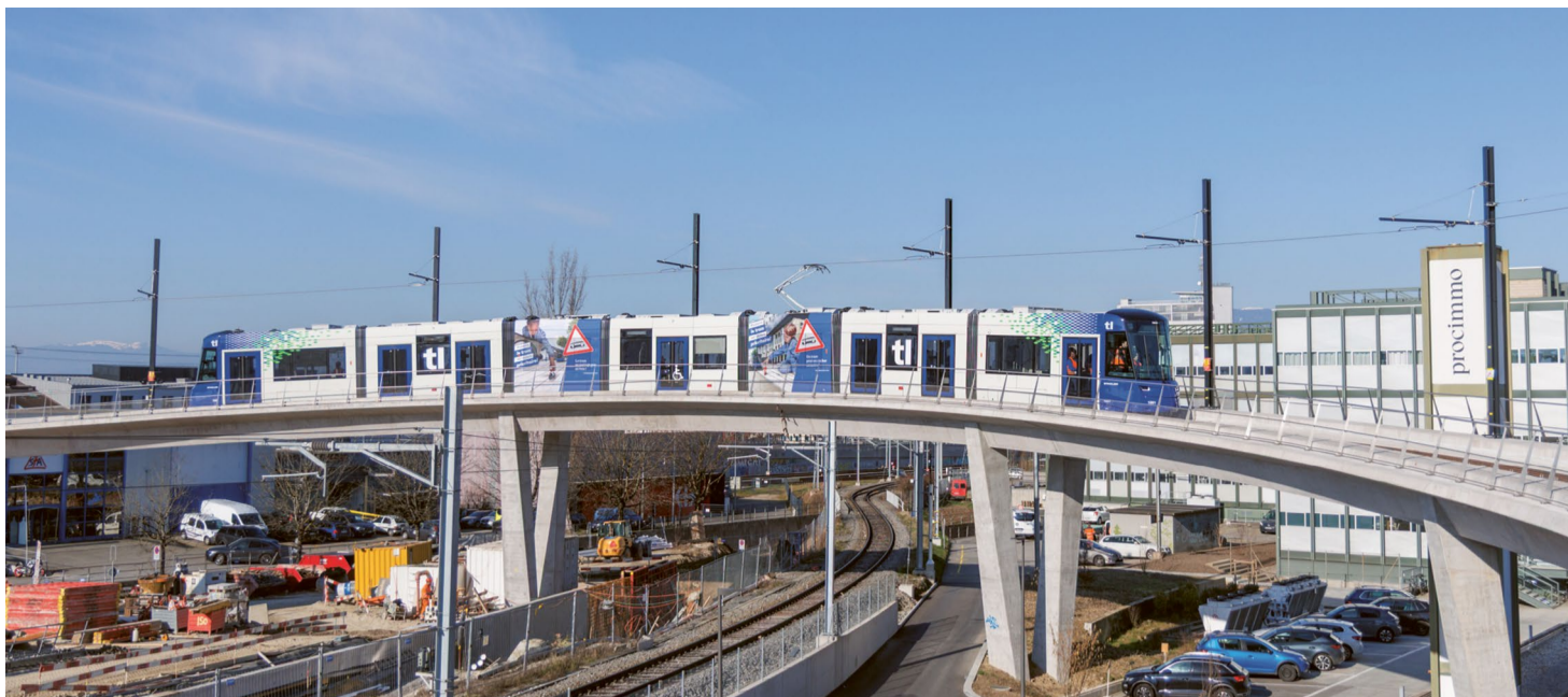
Construit en arc de cercle, le pont du Closel, à voie unique, permettra au tramway de rentrer chaque soir au dépôt et garage atelier.
