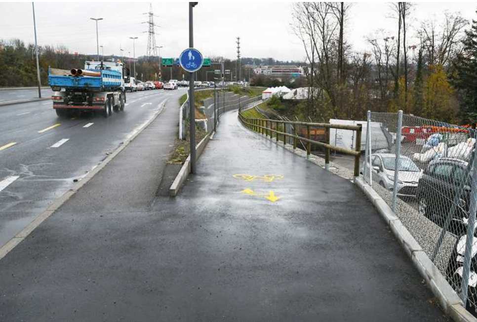
Coordonnés à d'autres projets, les éléments du réseau de mobilité douce se réalisent progressivement, parfois en site totalement protégé, comme ici dans le secteur de la jonction de Crissier, mais le plus souvent en regagnant une partie de l'espace routier optimisé ou libéré.
