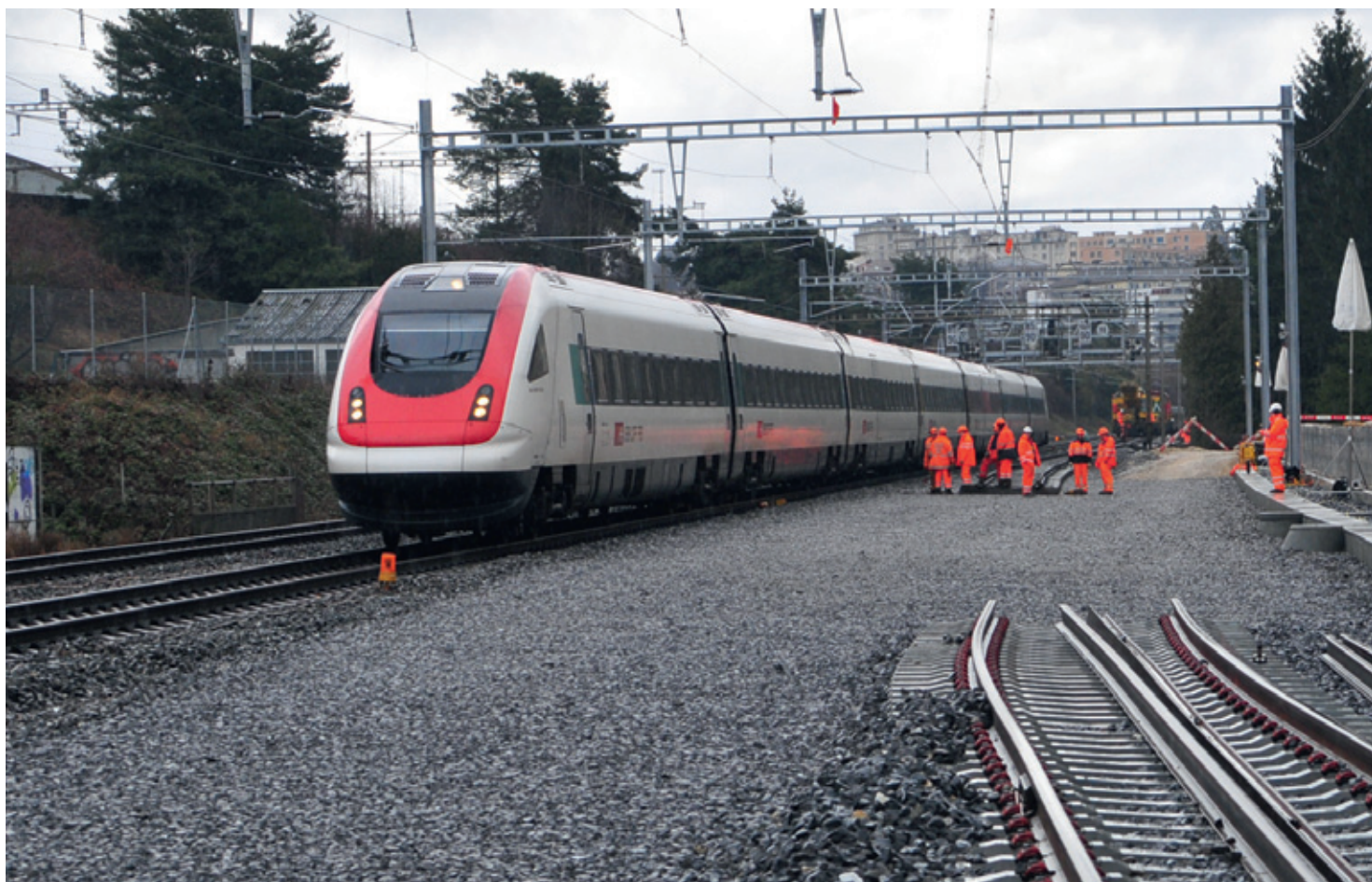
Poses de nouvelles voies entre Lausanne et Malley.
