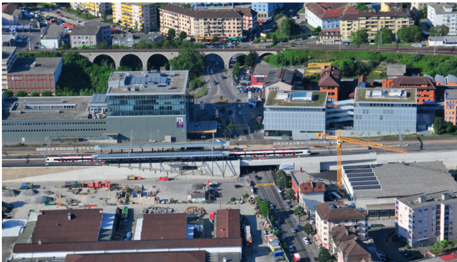
Halte RER de Prilly-Malley, en construction. Mai 2011.
