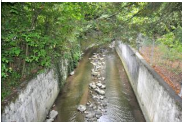
Cours aval de la Vuachère : exemple d'un tronçon à restaurer
