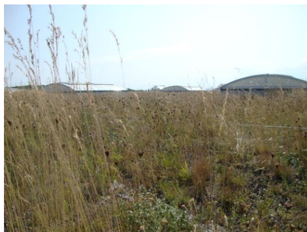
Toiture végétalisée (nouvelles halles Bobst à Mex)
