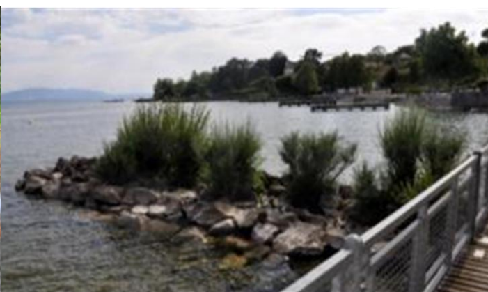
Exemple de relais implanté sur un épi (Nyon)
